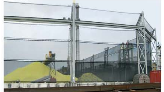
12 м экран отклоняет ветер с коксовой пылью от серного хранилища в Арубе.
