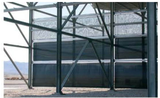
12м экран для градирни в Неваде отклоняет ветер и улучшает эффективность вентилятора.
